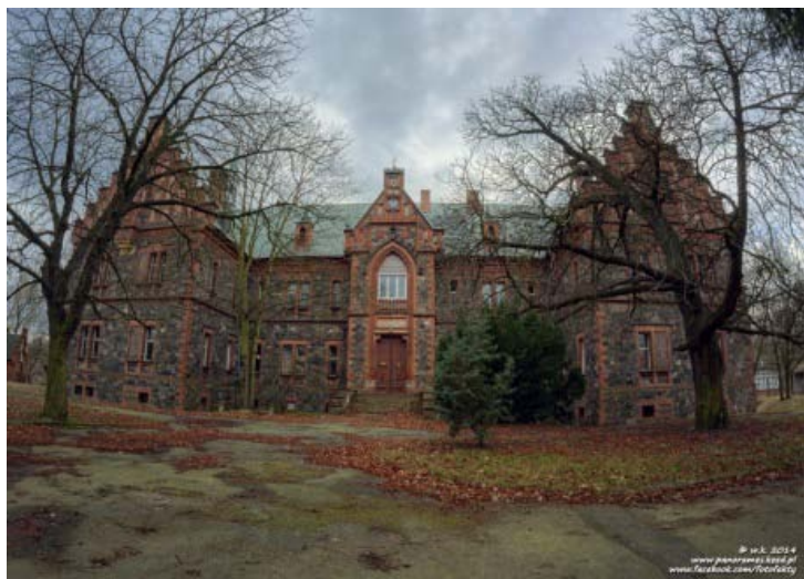
L'ancien hôpital (en travaux) fondé par Dorothee de Talleyrand-Périgord
